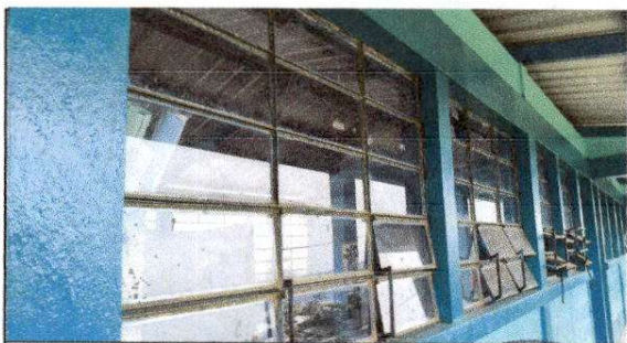
FOTO 5: Mantenimiento a estructura de metal de ventana
