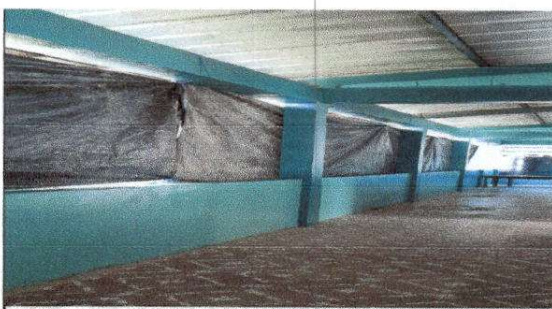
FOTO 12: Reparación de tubo hg y malla galvanizada
