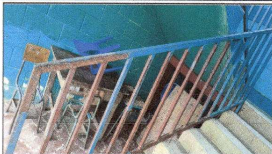
FOTO 7: Sustrucción de barandas de metal.
