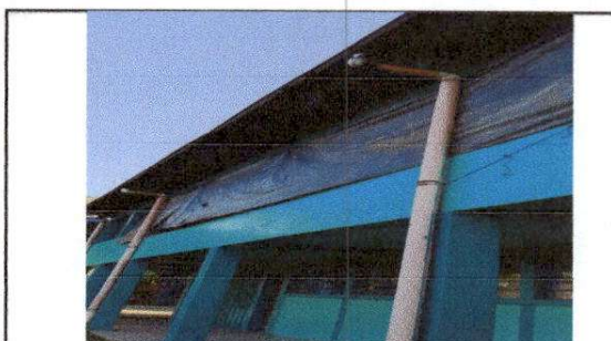
FOTO 10 : CANALES Y BAJADAS DE AGUA PLUVIAL
