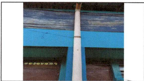
FOTO 11: Reparación de bajada de agua pluvial, tubo PVC
