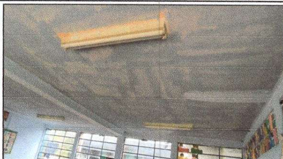
FOTO 8: Sustrucción de focos ahorradores
